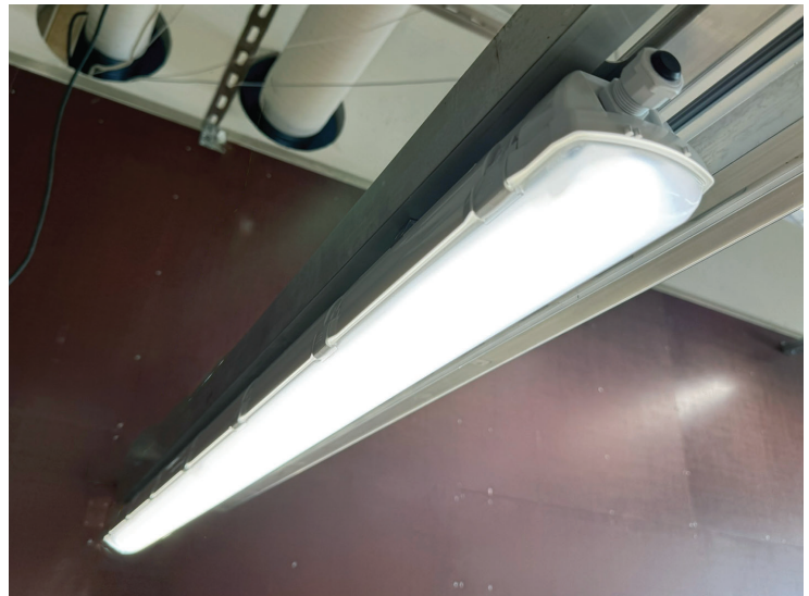
Opaali polykarbonaattikuori hajottaa valoa tehokkaasti
