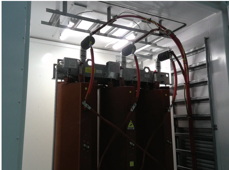
Avattavissa kiinnikkeissä on tärinää vaimentava kumieristys
